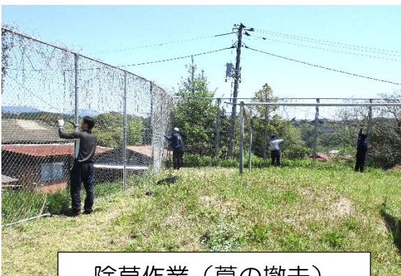
除草作業（蔦の撤去）
